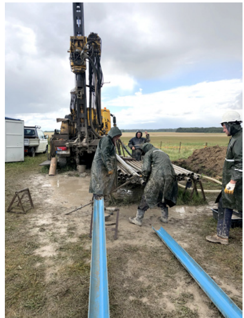
8 pav. Tiriamojo gręžinio įrengimas Šienlaukio vandenvietėje. R. Radienės nuotr.
