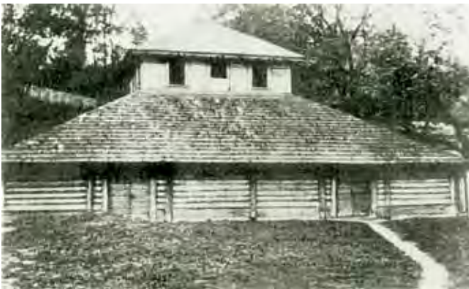
Vingrių šaltinių rezervuaro namas, 1912 m. (Jurkštas, 1990 m.)
